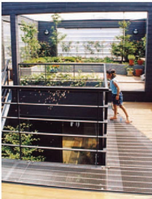
中庭の吹き抜けをはさんで広がる2階のデッキテラスは、床に光の透けるグレーチングを採用して階下を明るくしています。手前がLDK、奥が屋上ガーデン。
