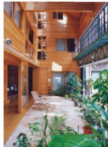
三層で風が吹き抜ける爽快なインナーテラス空間。2階のトラス梁の上はグレーチングの床板が設置され、窓掃除用のキャットウォークに。
